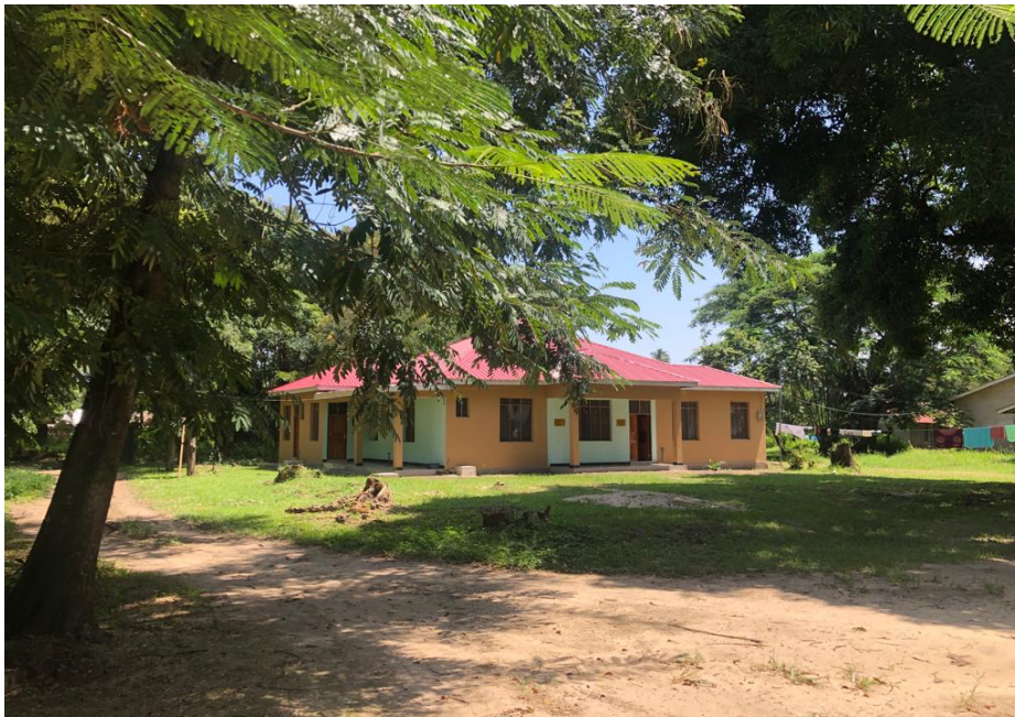
Het nieuwe' guesthouse
